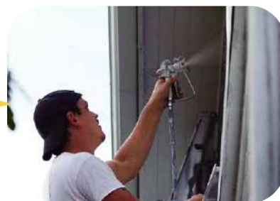
2. Apply primer (penetrating crystalline material)
