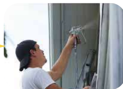
2. 塗抹底漆(滲透結晶材)
