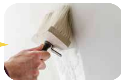
6. 最後，塗上保護性面漆完成
